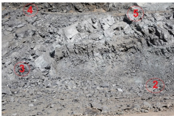
شکل ۱- بخشی از پله مورد مطالعه که در آن موقعیت چهار نقطه از نقاط کنترلی مشخص شده است (فاصله بین نقاط کنترلی ۳ و ۴، ۱۳/۹۵ متر می‌باشد).
