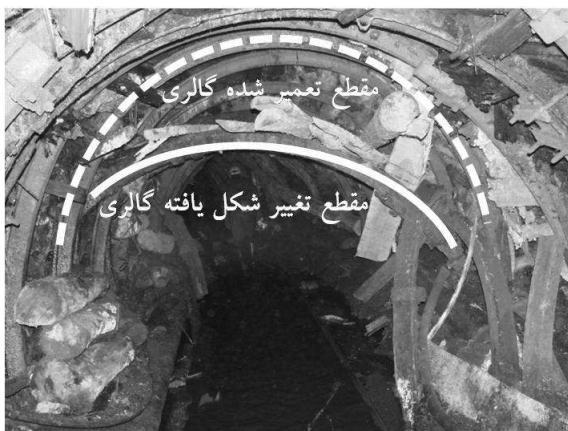
شکل ۳: نمایی از قسمت تعمیر شده گالری پست
