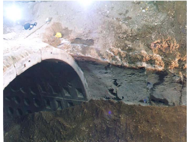
شکل ۴: زون خاک تزریق شده در عملیات تزریق قطعه S 2 -X 2
