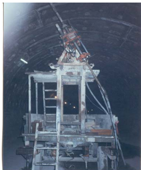
شکل ۶: حفر گمانه جهت مغزه‌گیری و اجرای آزمایش لوژان خط ۲ تونل متروی تهران S 2 -X 2 در قطعه
