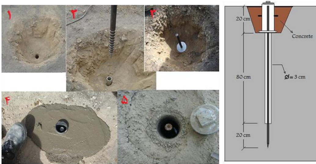
شکل ۷: ساختار پین مورد استفاده برای رفتارنگاری زمین
