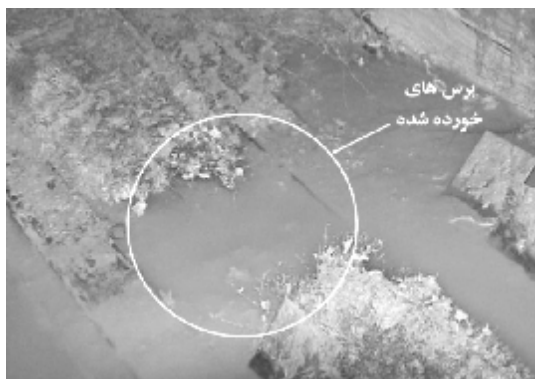
شکل ۸: از بین رفتن خاصیت آب بند کنندگی برس در اثر کنده شدن تکه ای از آن
