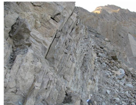
شکل ۷: شکست واژگونی در خروجی تونل انحراف آب سد مشمپای زنجان
